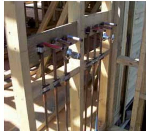
**43** Muros o tabiques de una vivienda que traen incorporados desde fábrica, las cañerías de agua potable (fría y caliente) con las piezas de refuerzos para fijarla a la estructura.
