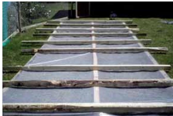
1 Aislación del suelo mediante colocación de polietileno y piezas de maderas (cuartones) que receptionan a la madera a encastillar.
